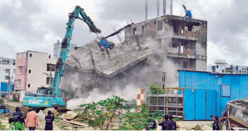
ఆదివారం మాదాపూర్ లో అక్రమ నిర్మాణాలను కూల్చివేస్తున్న హైద్రా
